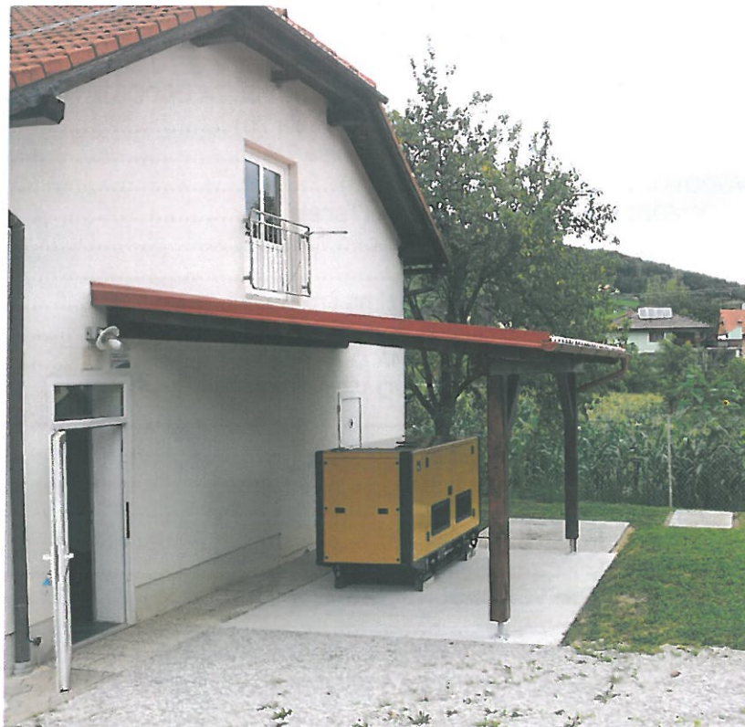
Nova pridobitev na področju oskrbe s pitno vodo (Agregat v ČNPV Žiče)
